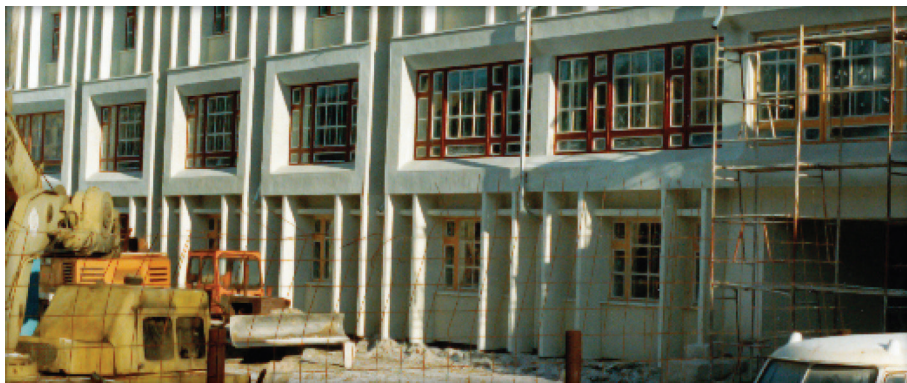
Corpul C în sept. 1994 cu finisajele exterioare aproape terminate
